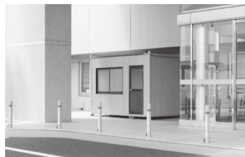
正面玄関横：トリアージ待機室
